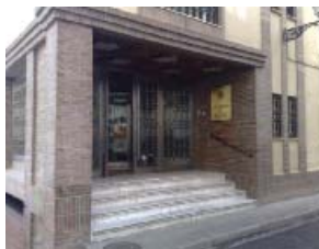
Entrada al Edificio Santa Lucía
